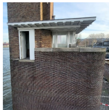
Landhoofd Oude Willemsbrug O
