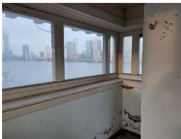
Landhoofd Oude Willemsbrug west
